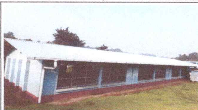
Foto 1: Finalización de instalación lamina troquelada.
