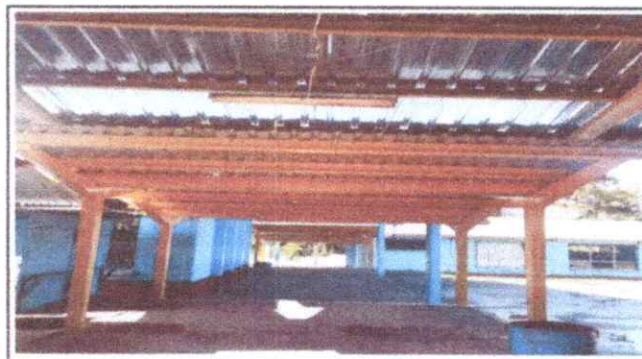
Foto 4: Finalización de la de la pintura sobre estructura existente.
