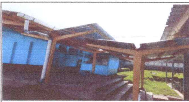
Foto 5: Finalización de instalación lamina troquelada y bajadas de agua.
