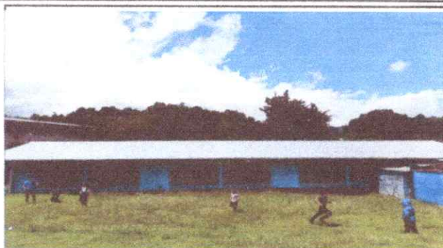
Foto 2: Finalización de instalación lamina troquelada.
